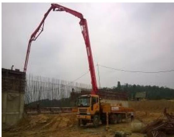
Bơm bê tông cần Jujin
